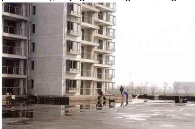
Hình 2: Xử lý chống thấm bề mặt sàn với SIKA
