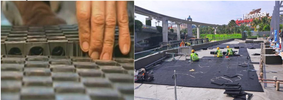
Hình 7: Lắp đặt tấm Drainage Cell
